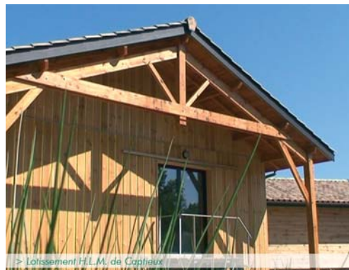
> Lotissement H.L.M. de Captieux
